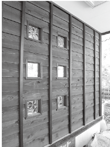
壁には『日本下見張り工法』を使用。この手法を伝える職人さんも少なくなっている
