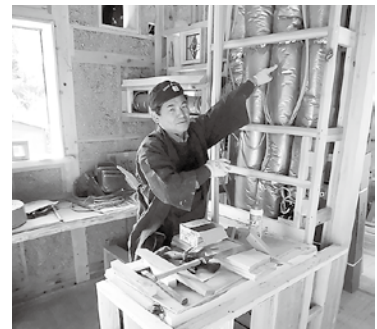
地中熱空調システムを説明する国立分会の小松さん。およそ15℃で安定している地中熱を利用することで夏涼しく、冬暖かい
